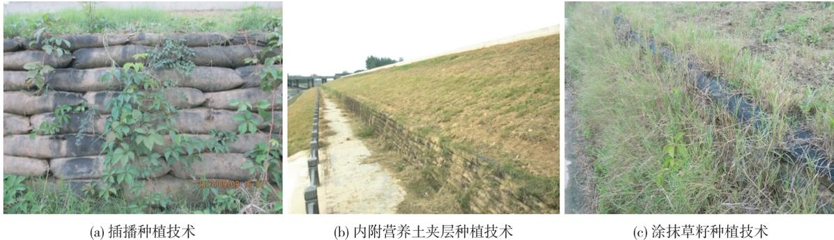
图2 试验段生态袋挡墙照片
