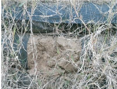
图4 生态袋破坏后袋内土体流失(2014-11-19)
